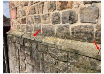
Abb. A2. Unteres Gesims mit rückgewittertem Abdeckstein sowie offenen Fugen.
